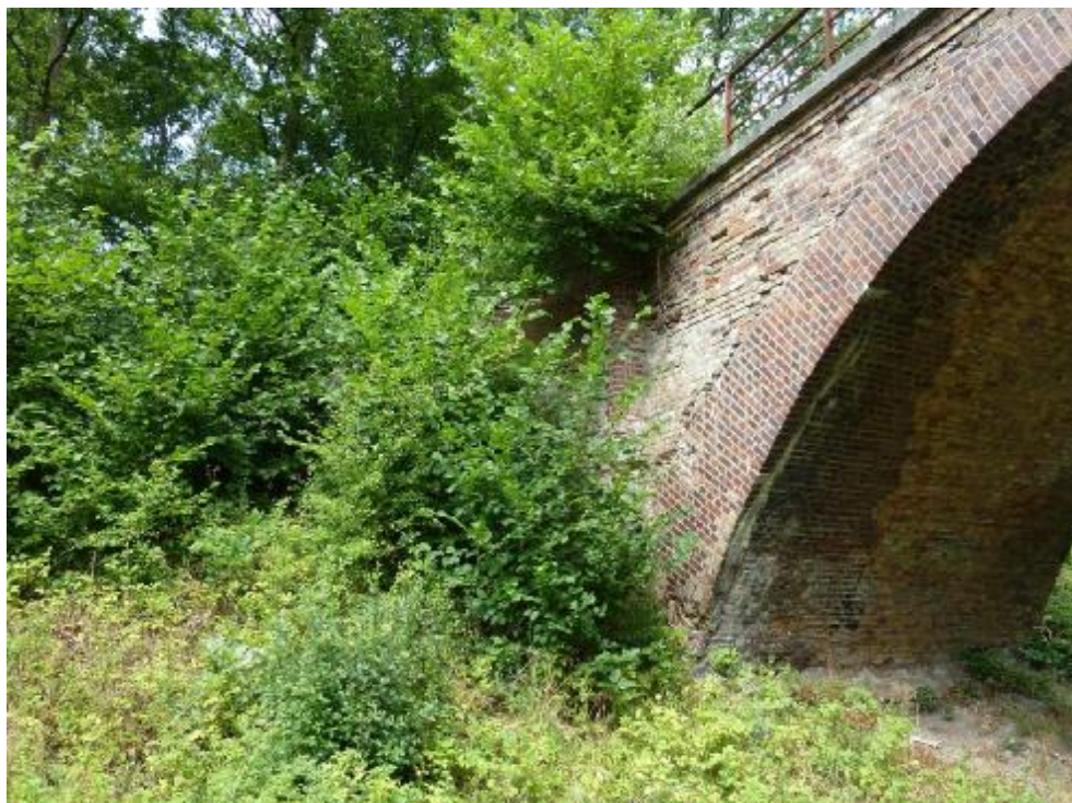
Zdjęcia 8. Skrzydło prawe od strony Sławskowa. Widoczne zaawansowane ubytki elementów ceglanych, liczne pęknięcia i zarysowania utrata wiązania w spoinach.
