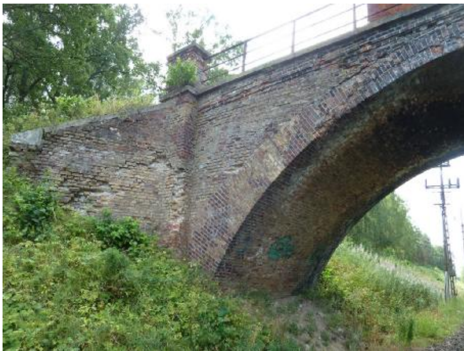
Zdjęcia 6. Skrzydło prawe od strony Warszkowa. Widoczne zaawansowane ubytki elementów ceglanych, liczne pęknięcia i zarysowania, utrata wiązania w spoinach.
