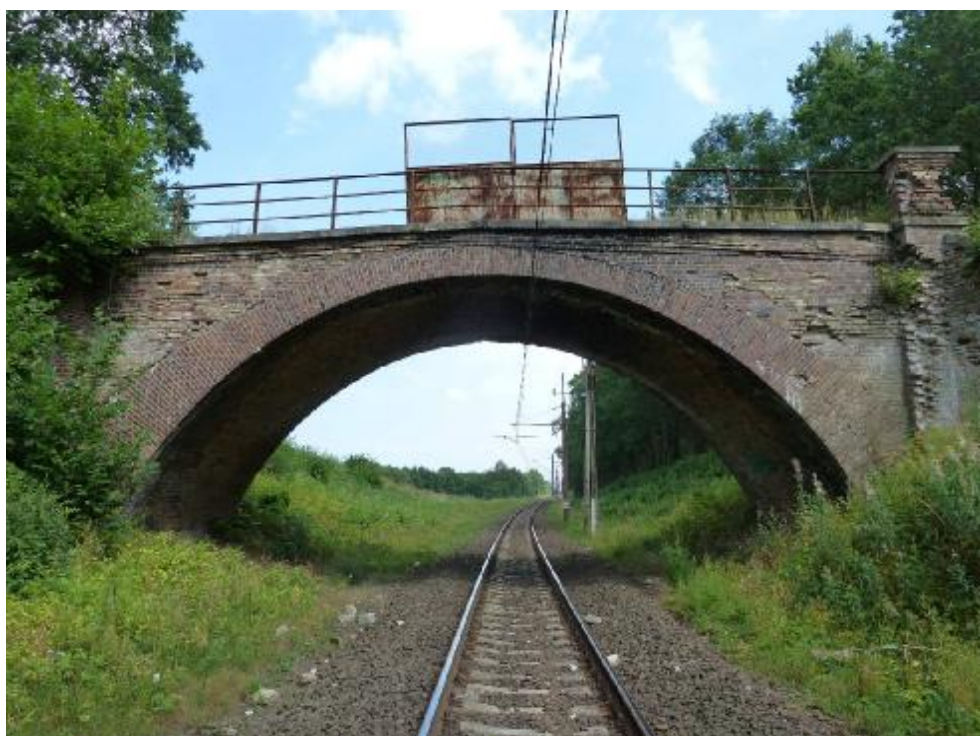
Zdjęcia 3. Widok z boku od strony Starogardu Szczecińskiego. Widoczne ubytki elementów ceglanych, przecieki, wykwyty i osady świadczące o korozji materiału.
