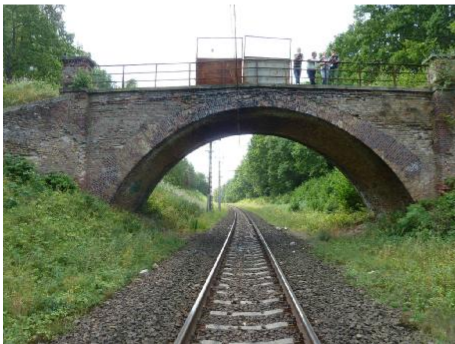
Zdjęcia 4. Widok z boku od strony Gdańska. Widoczne ubytki elementów ceglanych, przecieki, wykwyty i osady świadczące o korozji materiału.
