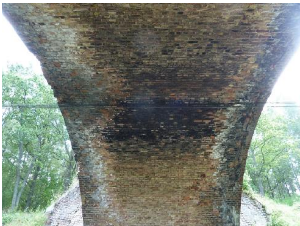
Zdjęcia 5. Widok spodu konstrukcji sklepienia. Widoczne ubytki elementów ceglanych, przecieki, wykwyty i osady świadczące o korozji materiału i nieszczelnej izolacji.
