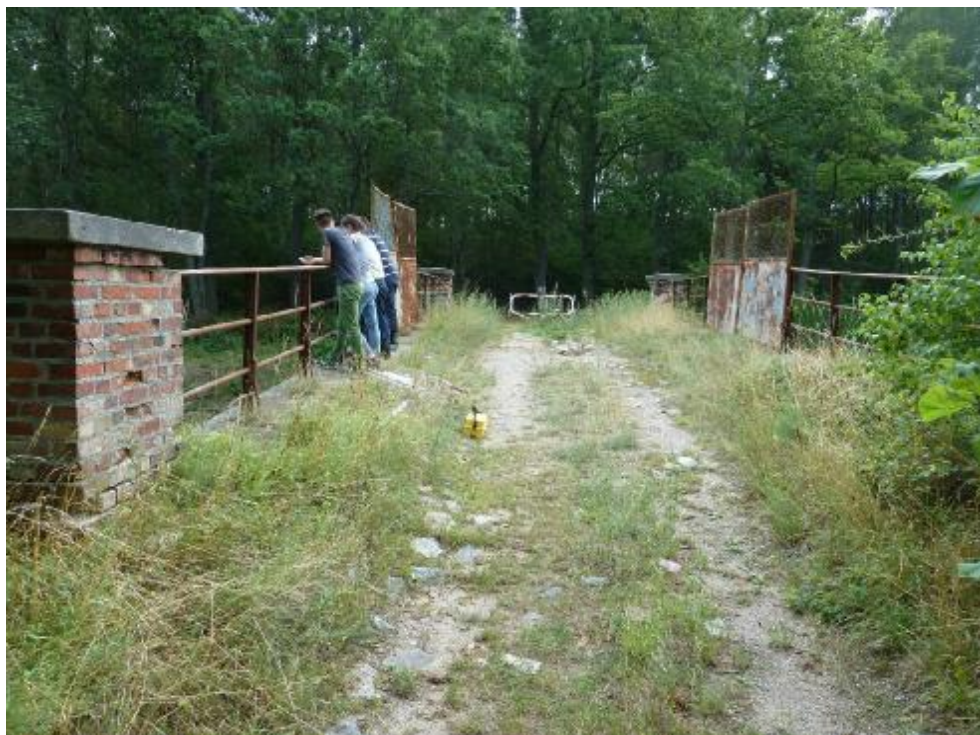
Zdjęcie 2. Widok na obiekcie z poziomu jezdni. Widoczne uszkodzenia nawierzchni, wegetacja roślinności i korozja balustrad i osłon trakcji.
