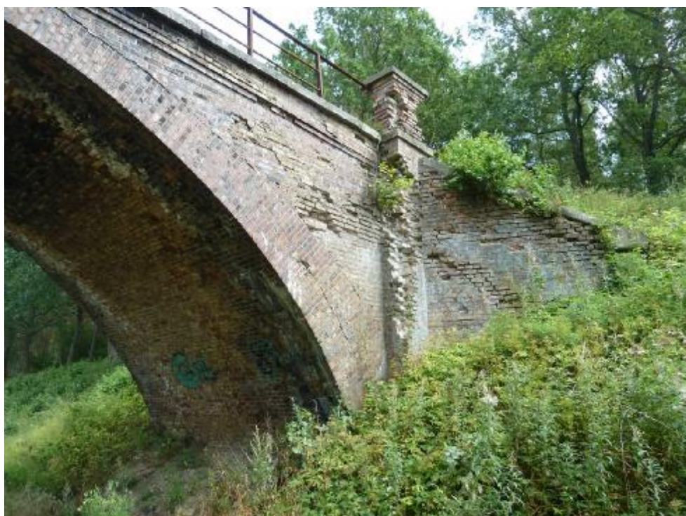
Zdjęcia 7. Skrzydło lewe od strony Warszkowa. Widoczne zaawansowane ubytki elementów ceglanych, liczne pęknięcia i zarysowania, utrata wiązania w spoinach.
